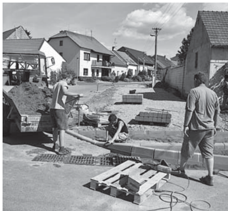
Na křižovatce ulic Trávníky a Ořechová byla vybudována nová parkovací místa.
