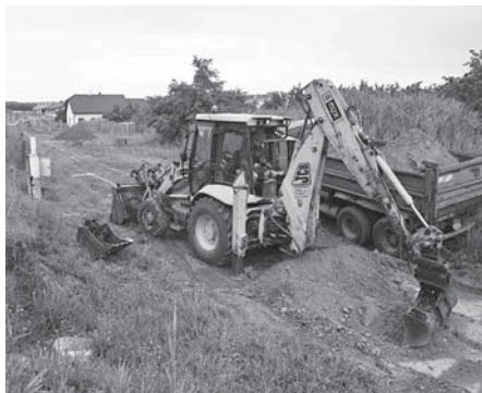
V lokalitě Padělky se začalo v červenci s budováním nové vozovky, na Ostrovecké.
