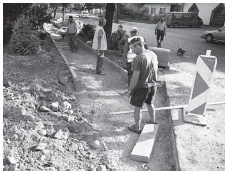
Demolice starého chodníku na Hlavní ulici.
